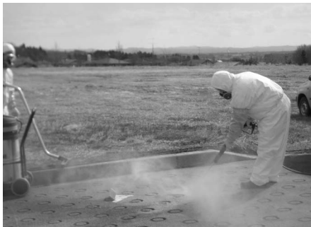
写真【1】高圧洗浄除染の様子
